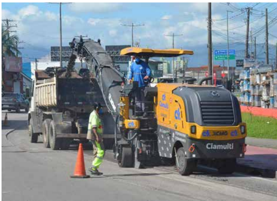
Na noite da última quarta-feira (12), o prefeito Mateus acompanhou o andamento das obras na altura da rotatória
