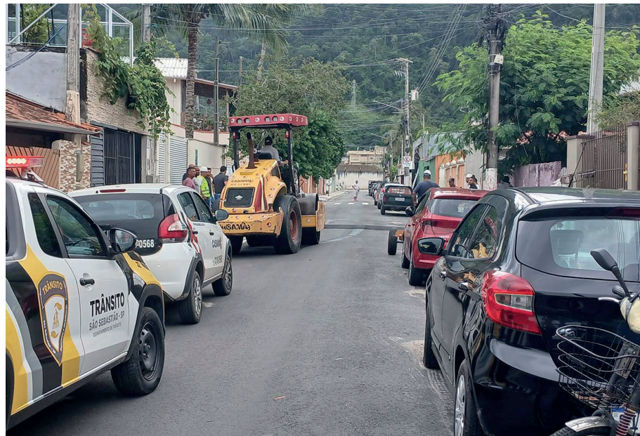
A medida atende a demandas da comunidade e visa a prevenção de acidentes, promovendo um tráfego mais seguro devido a presença de diversas escolas na localidade
